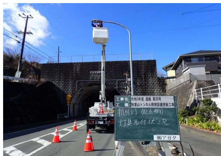
施工状況 (坑外灯)
