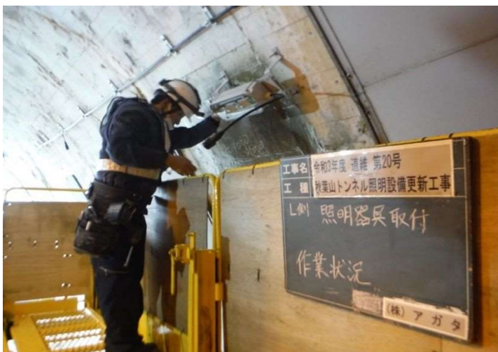
施工状況 (照明取付)
